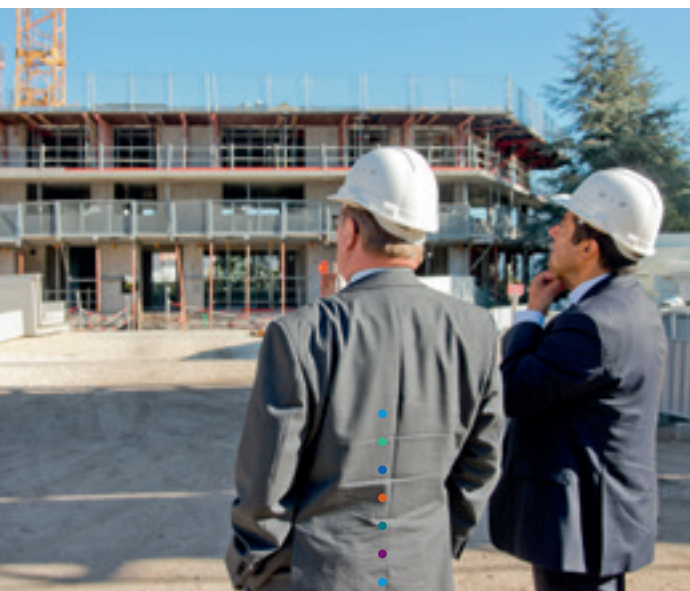
Chantier logements étudiants à Nanterre
